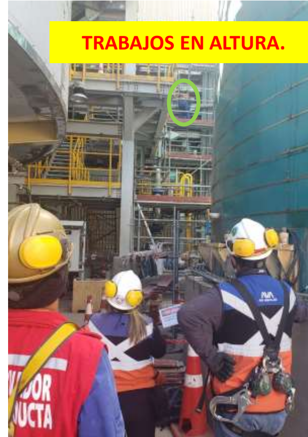
INSPECCIÓN DE TRABAJOS EN ALTURA.
