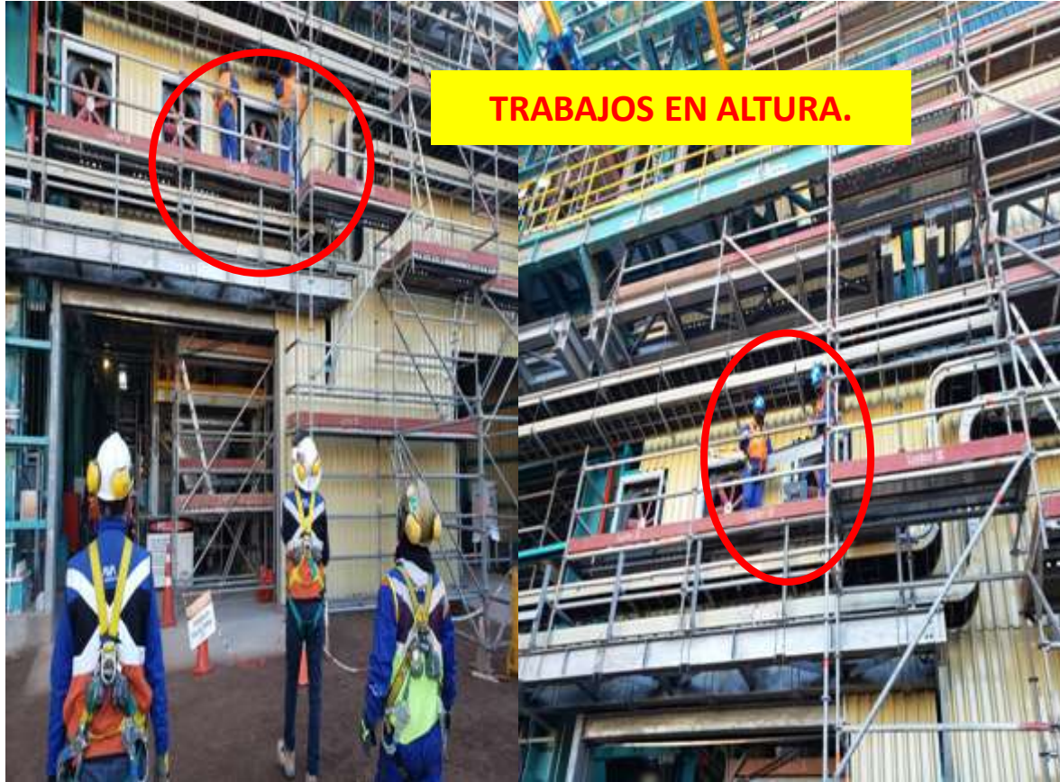
INSPECCIÓN DE TRABAJOS EN ALTURA Y REFORZAMIENTO AL PERSONAL OBSERVADO.
