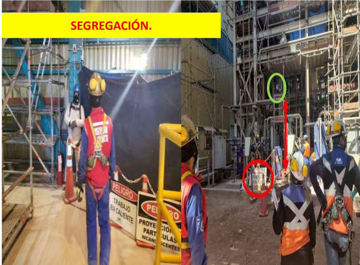
INSPECCIÓN DE SEGREGACIONES DE ÁREA DE TRABAJO Y EL RESPETO HACIA ESTAS.
