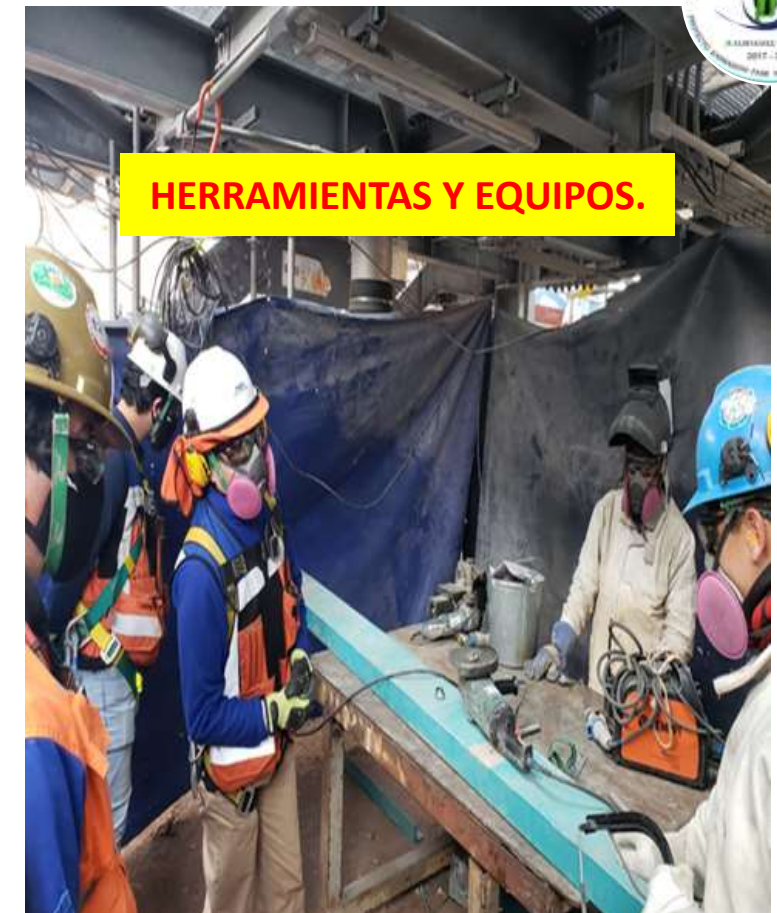
INSPECCIÓN DEL CORRECTO USO DE HERRAMIENTAS ELÉCTRICAS.
